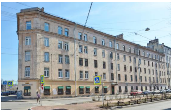
Рис. 2. Фасад жилого дома в настоящее время. Вид со стороны 14-й линии Васильевского острова ( https://dzen.ru/a/Z_453CRUW014qo7i )
